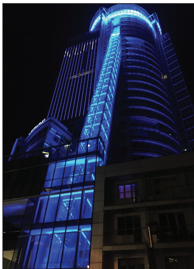
„Zaświeć się na niebiesko” - Warsaw Spire
